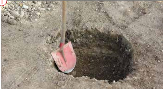
Mit einem Spaten eine Grube ausheben in den Abmessungen 50 x 50 x 50 cm. Der Boden sollte eben sein.
