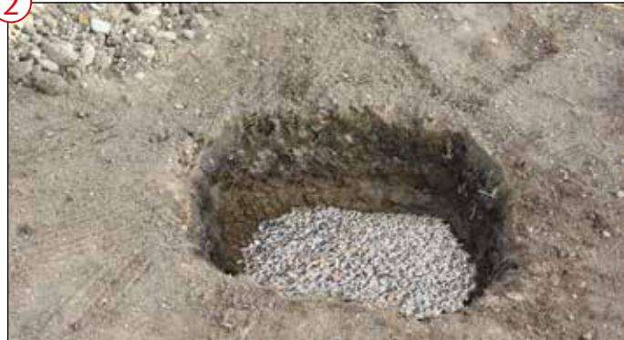
Den Boden mit 1 – 2 cm Kies oder Splitt bedecken und einen Zollstock an einem im Boden eingeschlagenen Stab befestigen.
